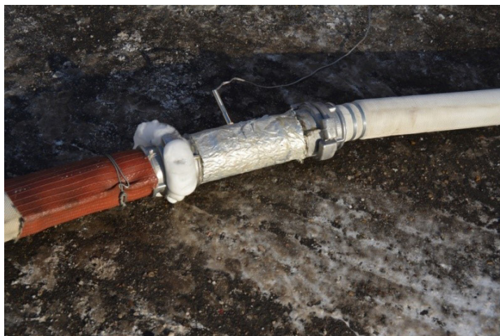
Рис. 4. Подключение рукавной вставки с температурным датчиком в насосно-рукавную систему при подаче компрессионной пены
