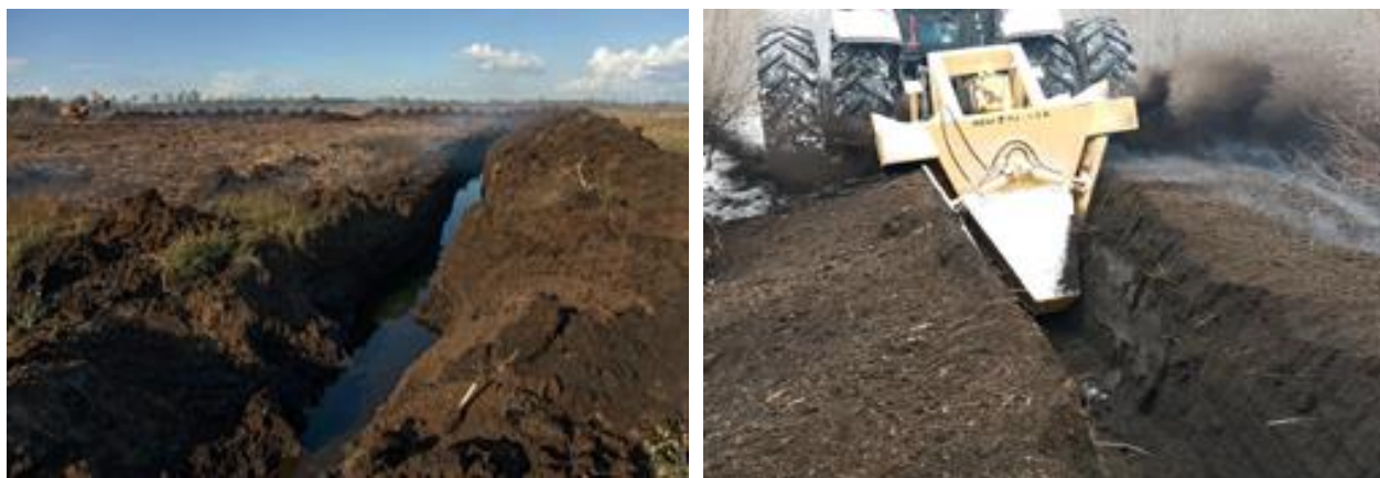
Рисунок 8. Создание канав (траншей)
