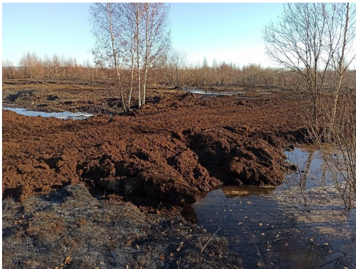
Рисунок 9. Не переливная торфяная плотина (перемычка)
