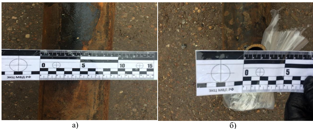
Рисунок 1. Подготовка оборудования: а) участок трубопровода; б) патрубок с заглушкой
