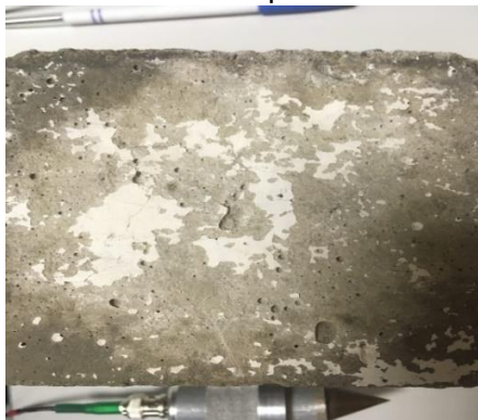
Рис. 1. Подготовленная поверхность МБ для нанесения ТИП
