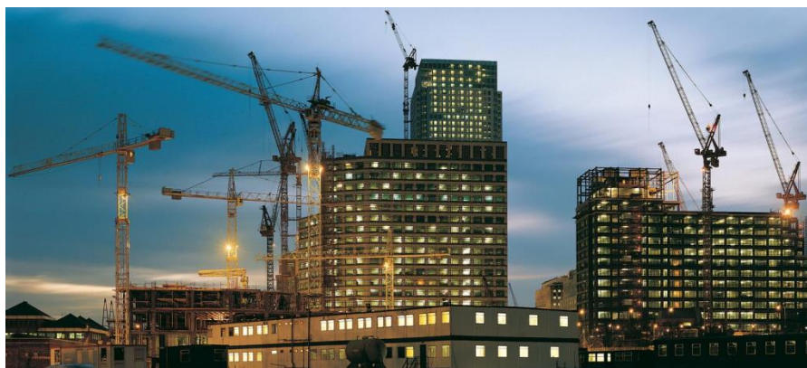
Рисунок 3. Подъёмные краны на строительстве многоэтажных зданий
