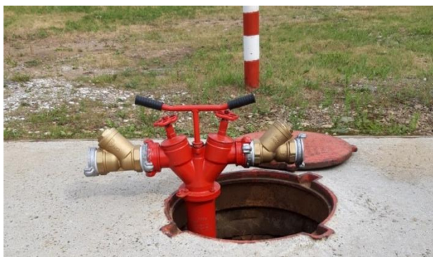
Рисунок 3. Фильтры грубой очистки воды, установленные на пожарную колонку
