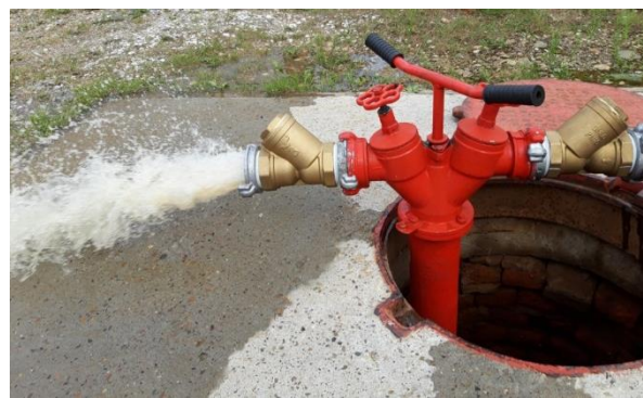
Рисунок 4. Пуск воды через фильтр грубой очистки
