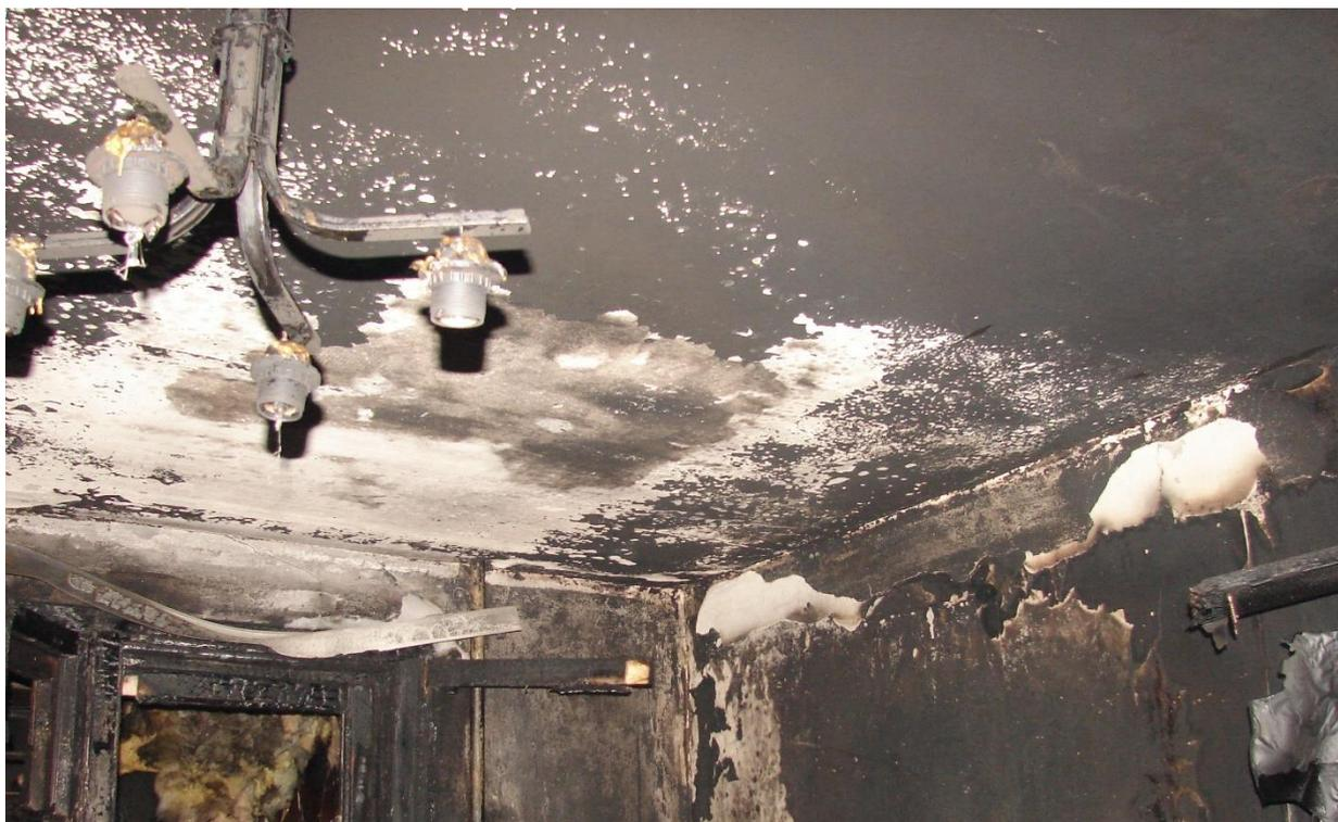
*Рисунок 3. Железобетонные конструкции после пожара. Участки выгорания копоти свидетельствуют о нагреве поверхности конструкции выше 600 °С*
