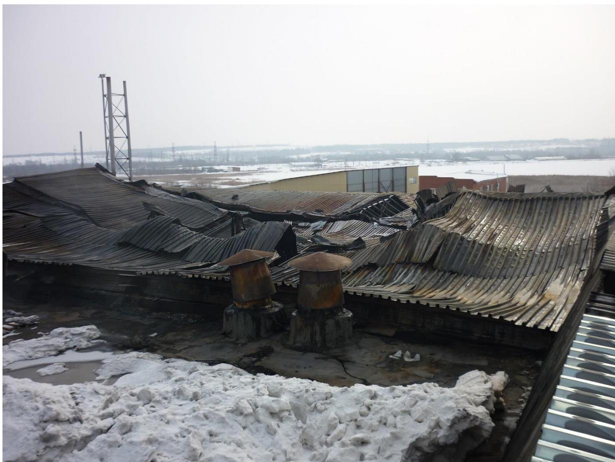
*Рисунок 2. Нависание профилированных стальных конструкций над производственно-складскими помещениями после пожара*
