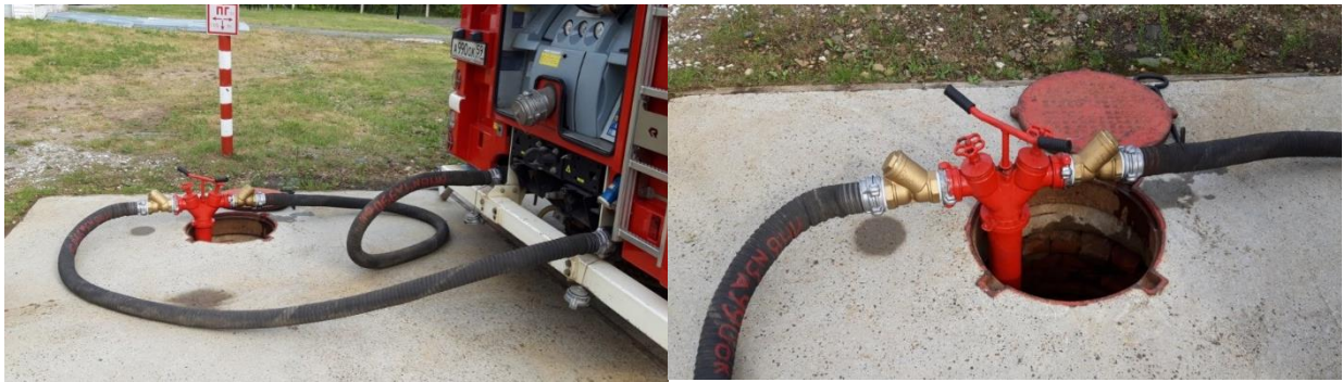
Рисунок 5. Установка пожарного автомобиля (АЦ) на пожарный гидрант с фильтрами
