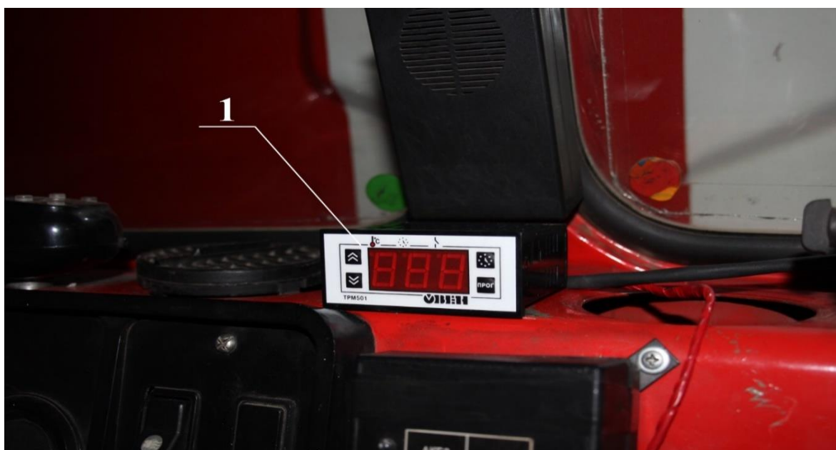
Рисунок 6. Расположение показывающего прибора ТРМ501 на панели приборов в кабине водителя: 1 – прибор ТРМ501
