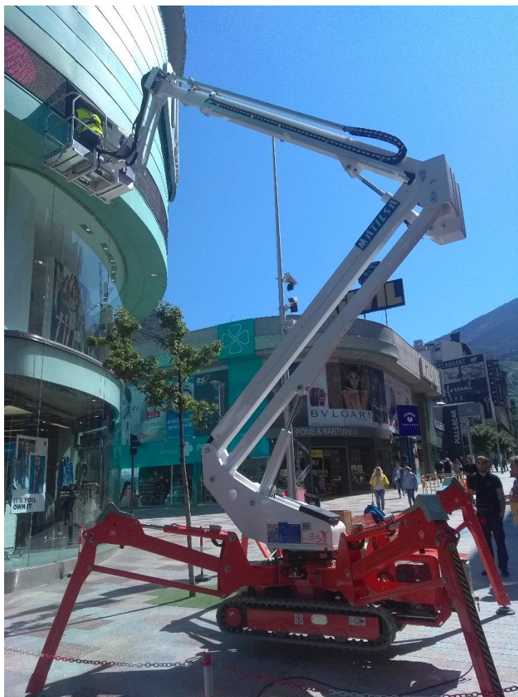
Рисунок 2. Обслуживание низкоэтажных конструкций зданий «малым» механизмом
