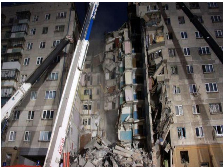
Рисунок 1. Разбор конструкций жилого дома после взрыва бытового газа в Магнитогорске 31.12.2018 года (Фото: BBC News Русская служба)
