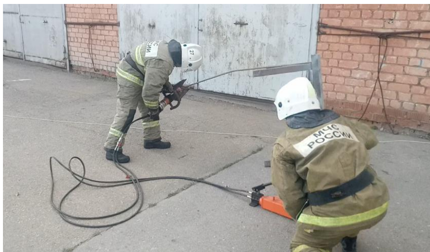
Рисунок 4. Процесс перекусывания арматуры
