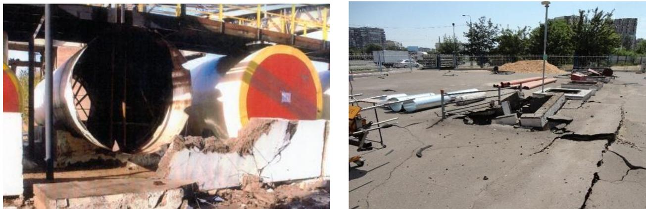
Рисунок 1. Примеры последствий взрыва наземного и подземного РГС в период их ремонта [1]
