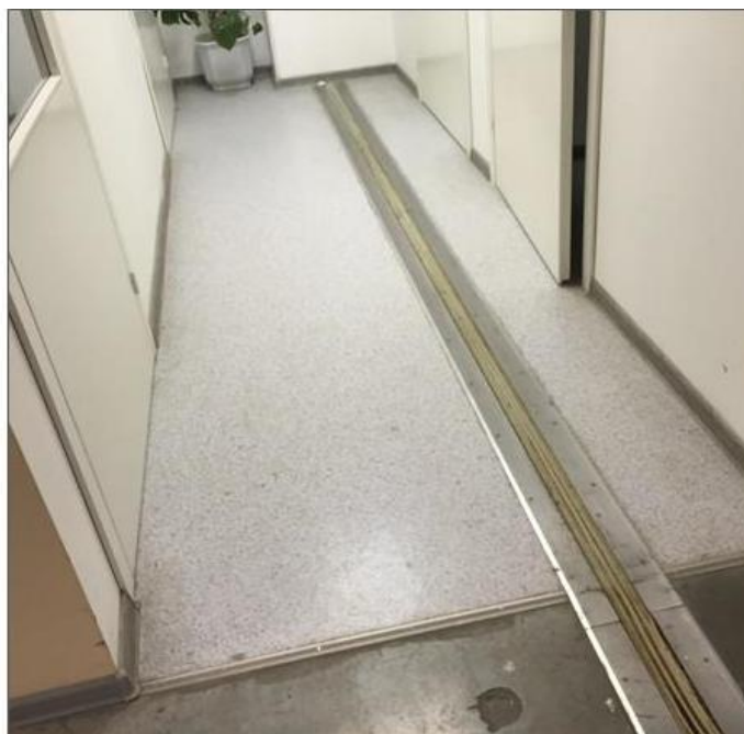
Рисунок 3. Устройство деформационных швов
