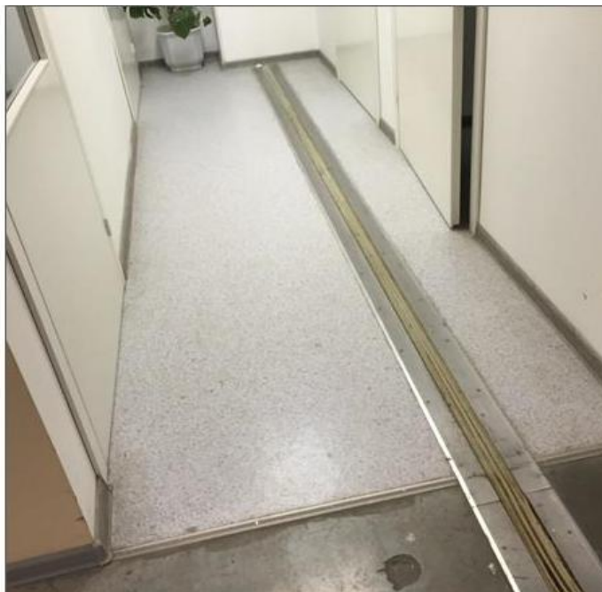
Рисунок 3. Устройство деформационных швов
